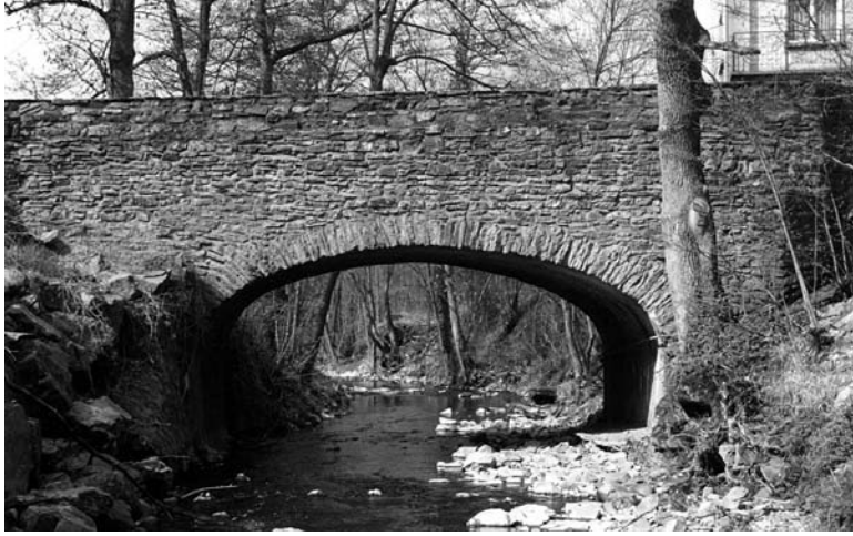
Fig. 6 Pont de Marienfloss ou pont Lamort (1859).
